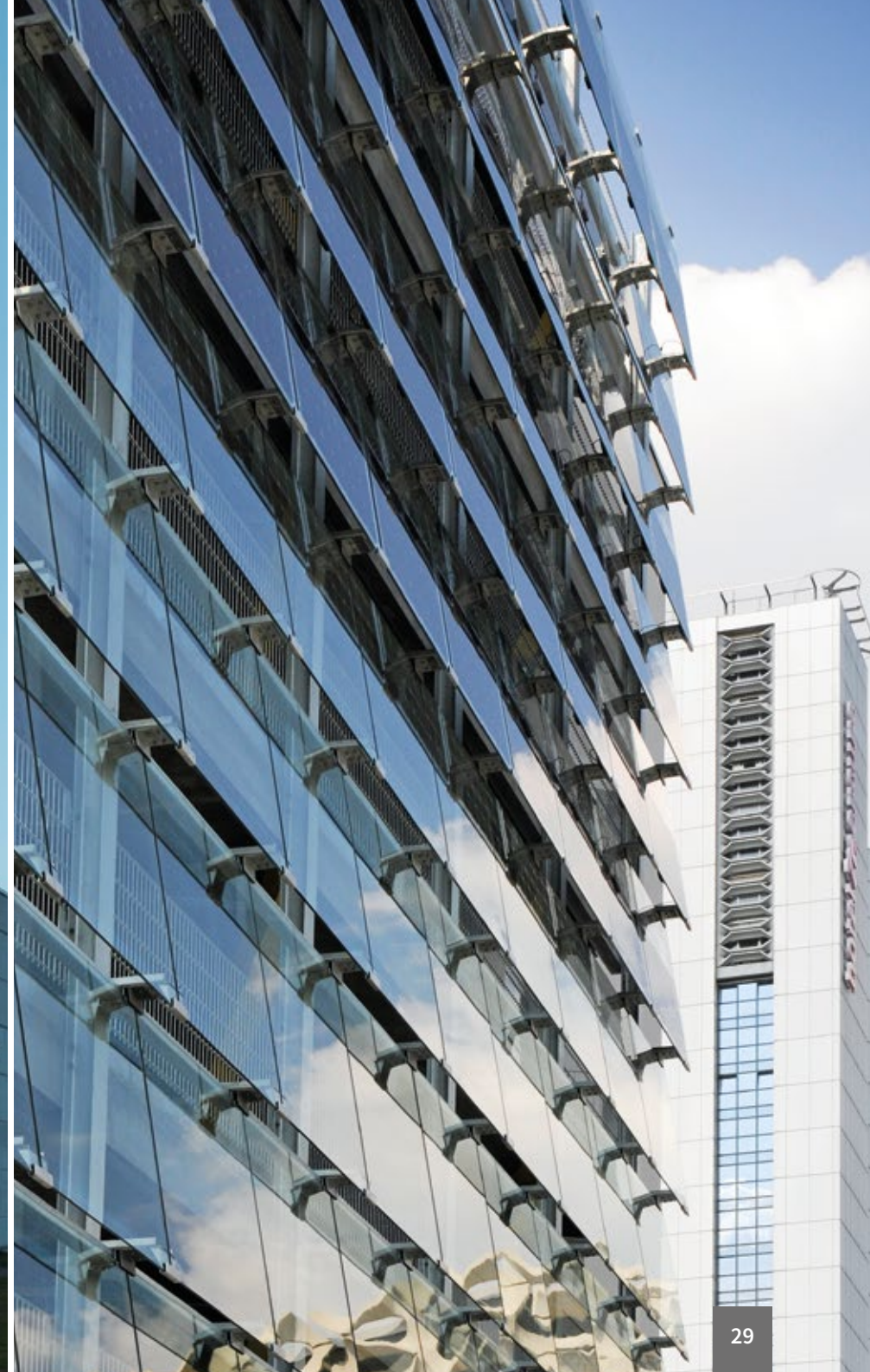
Bild rechts: Roter Turm, Dresden – Die Umweltbilanz des neuen Parkhauses „Roter Turm“ macht dem Stadtlogan der sächsischen Metropole „Stadt der Moderne“ alle Ehre. Die Shadovoltaik Solarmodule erzeugen rund 45.600 Kilowattstunden Strom pro Jahr.
